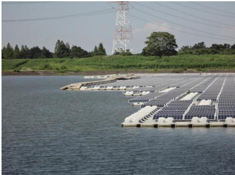
超出浮体架台边缘部分的电池板翻倒
